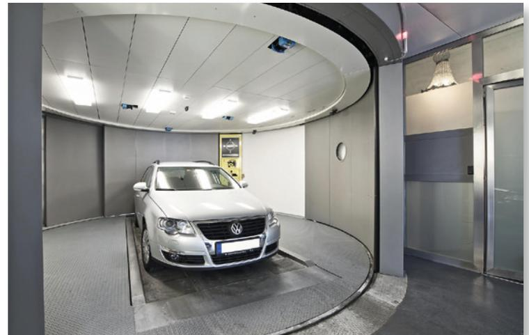
Die barrierefreie Übergabestation wird je nach Bedarf für Ein- und/oder Ausfahrtvorgänge genutzt
